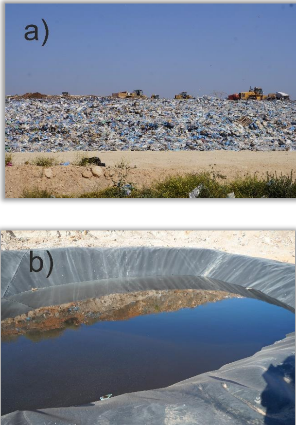
Figure 3 . CET Hassi Bounif, a) Casier de décharge et b) Bassin de collection de lixiviat
